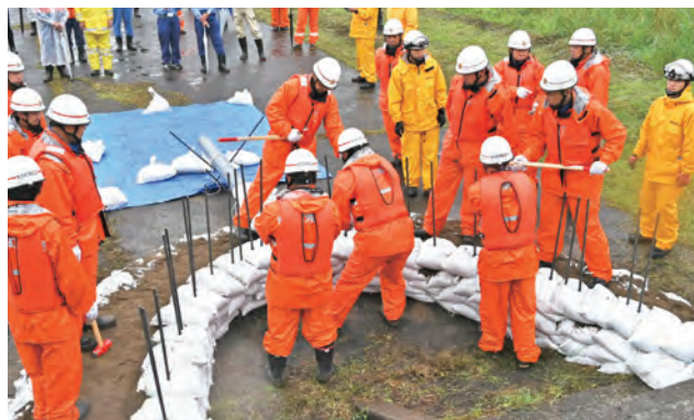
▲堤防の決壊を防止する月の輪工法の訓練
