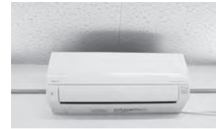
整備されたエアコン
