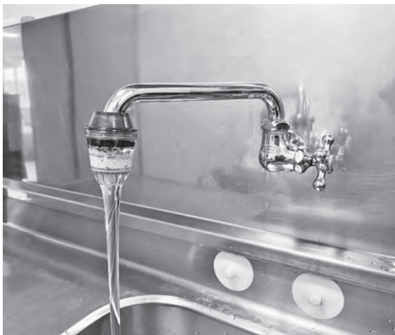
水道管の更新や維持管理には多くの費用が必要
