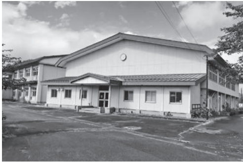
埋蔵品の収納箇所となっている旧西根小学校
