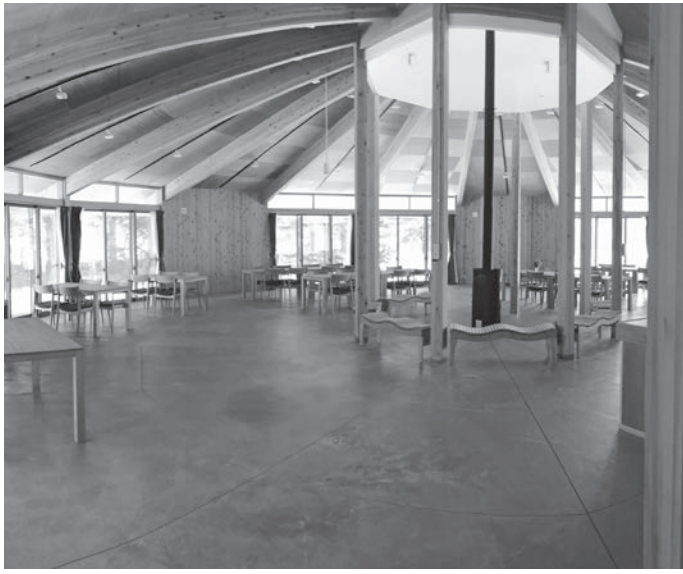
望まれる公共施設全室へのエアコン設置
