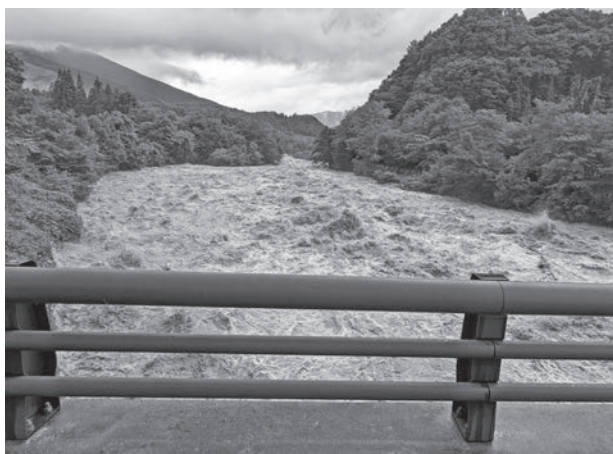
水位が3m 20cmに上がった館篠橋付近
