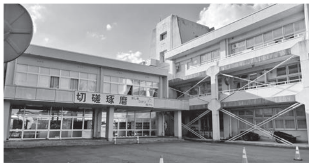
防犯システムの設置で学校の安全を強化
