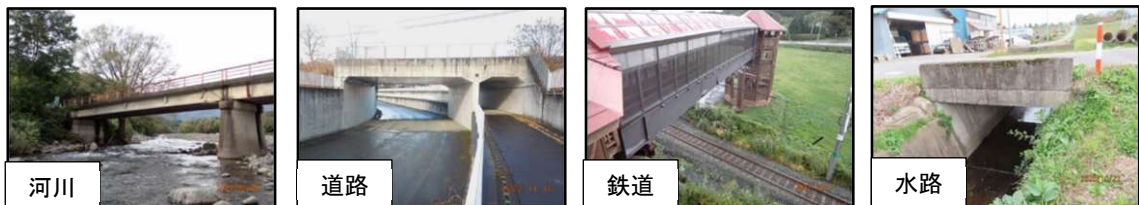
図 2.6 橋梁状況(交差条件別)
