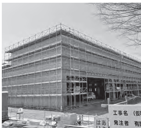
新工場の建設が進む(有)川井林業
