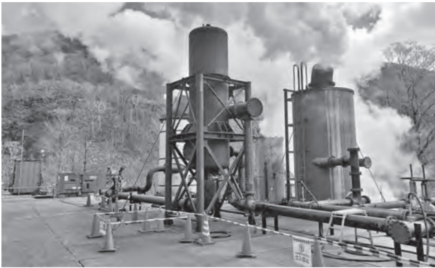
新たな地熱発電に期待される大松倉の試験地
