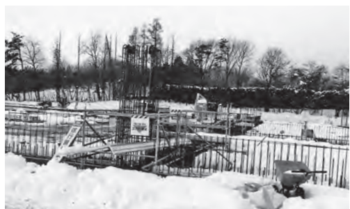
増設工事中の製材工場
