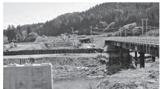
着々と工事が進む待望の新昇瀬橋
