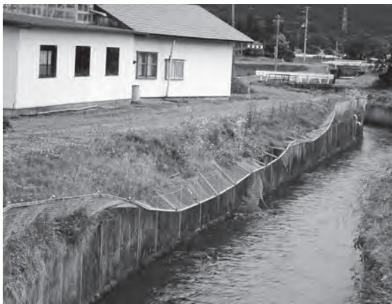
人命にかかわる整備が急がれる安全施設
