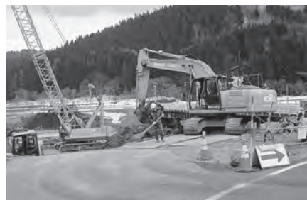
工事が進む昇瀬橋架け替え事業
