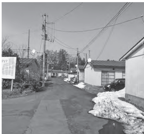
移住定住を支援するため整備を検討している町営住宅
