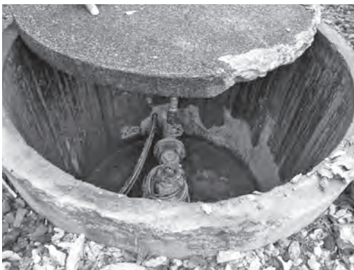
更新により安定した給湯量を目指す 玄武温泉のポンプ
