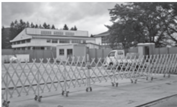
工事着工したアーチェリー屋内射場
