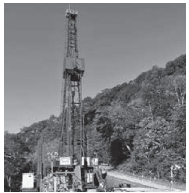
大松倉地域の試掘の状況
