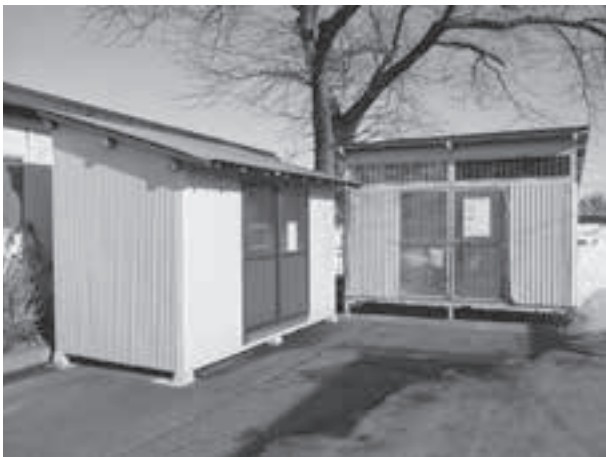
整備されたごみ収集所・資源ごみストックヤード
