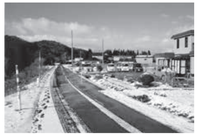
水道整備が待たれている矢櫃地区の矢櫃公民館付近
