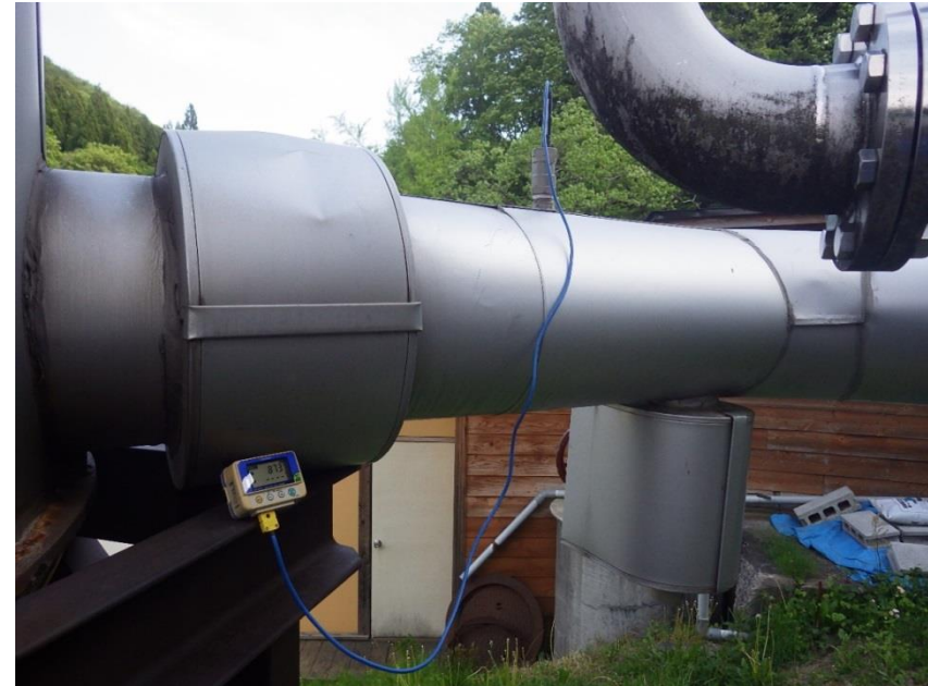
圧力測定装置設置(例)
