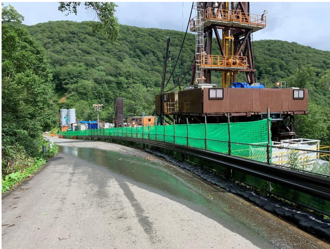
フェンス設置状況
