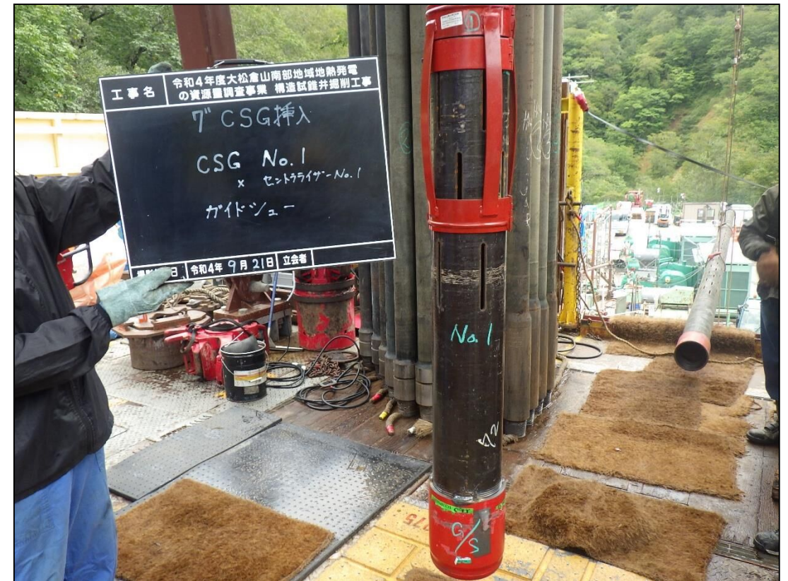
掘削作業状況
