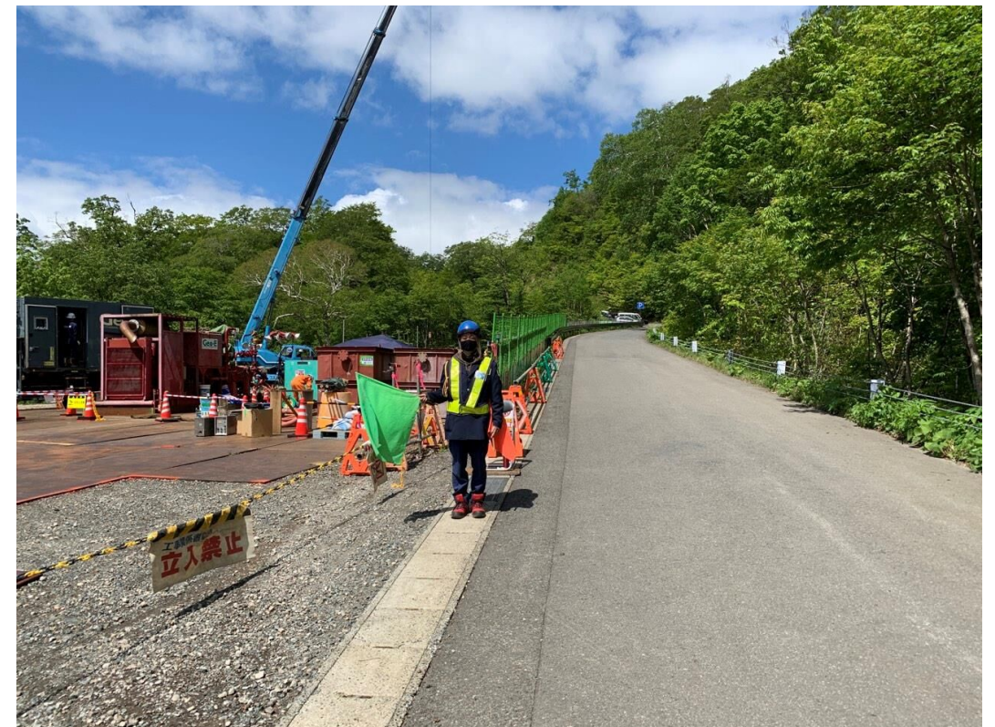
交通誘導員配置状況
