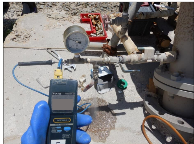
蒸気モニタリング(坑口の温度測定)
