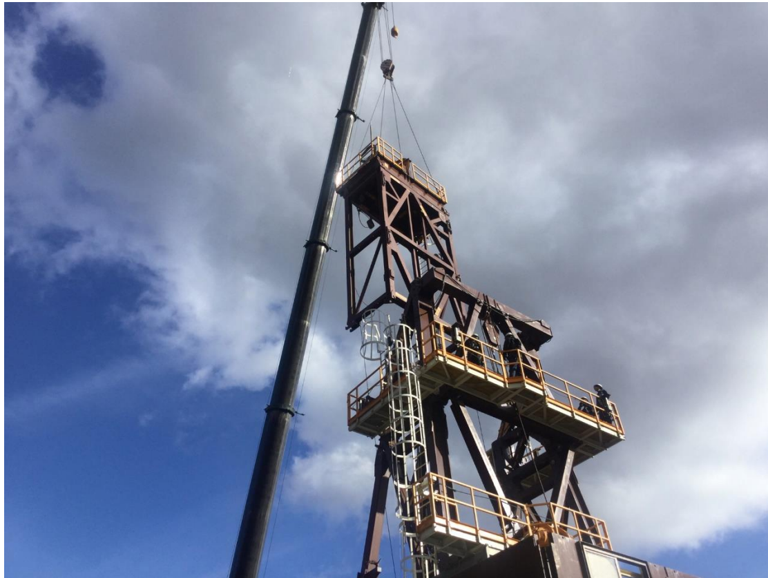
掘削リグ(やぐら部)
