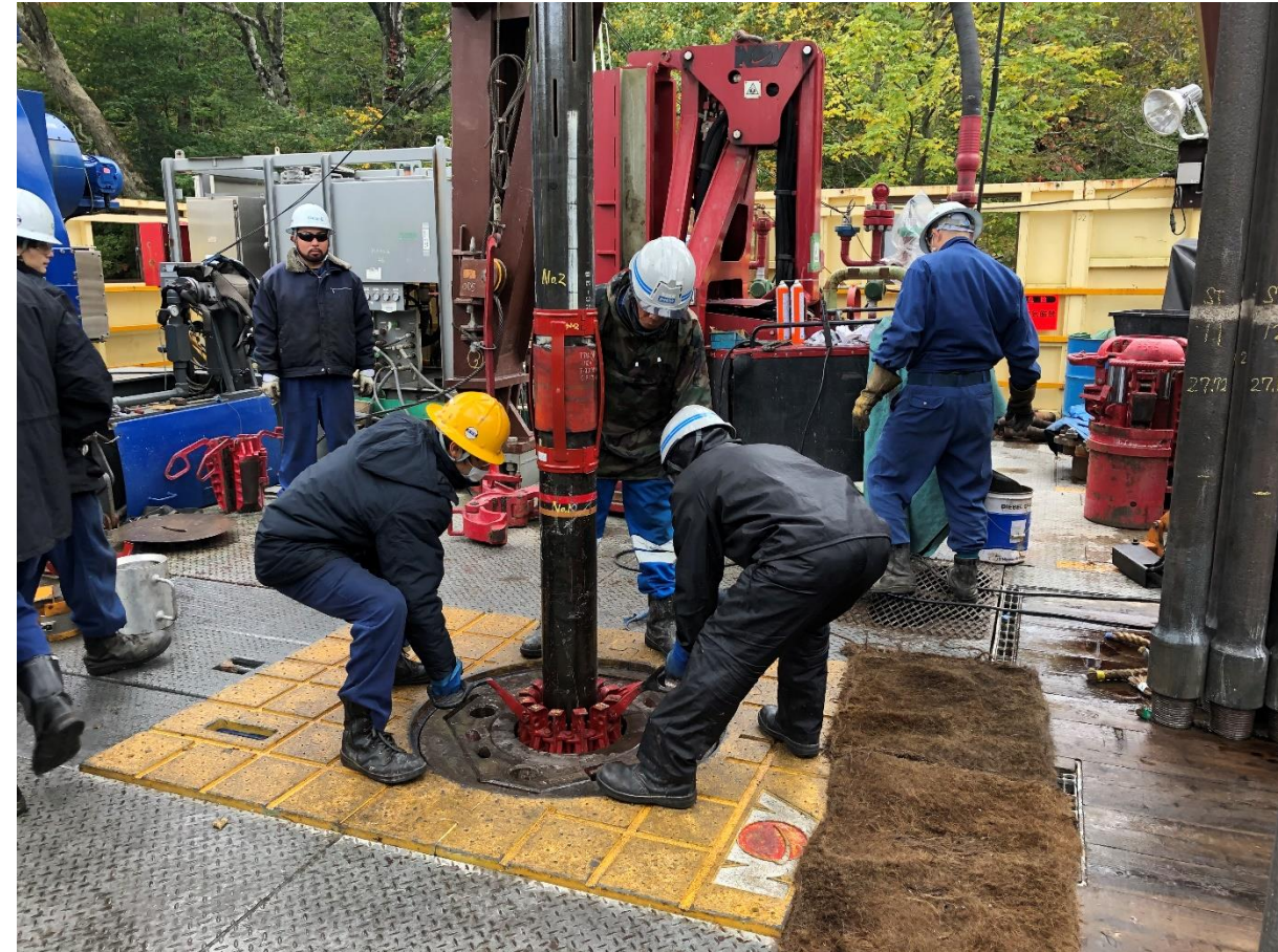
掘削作業状況
