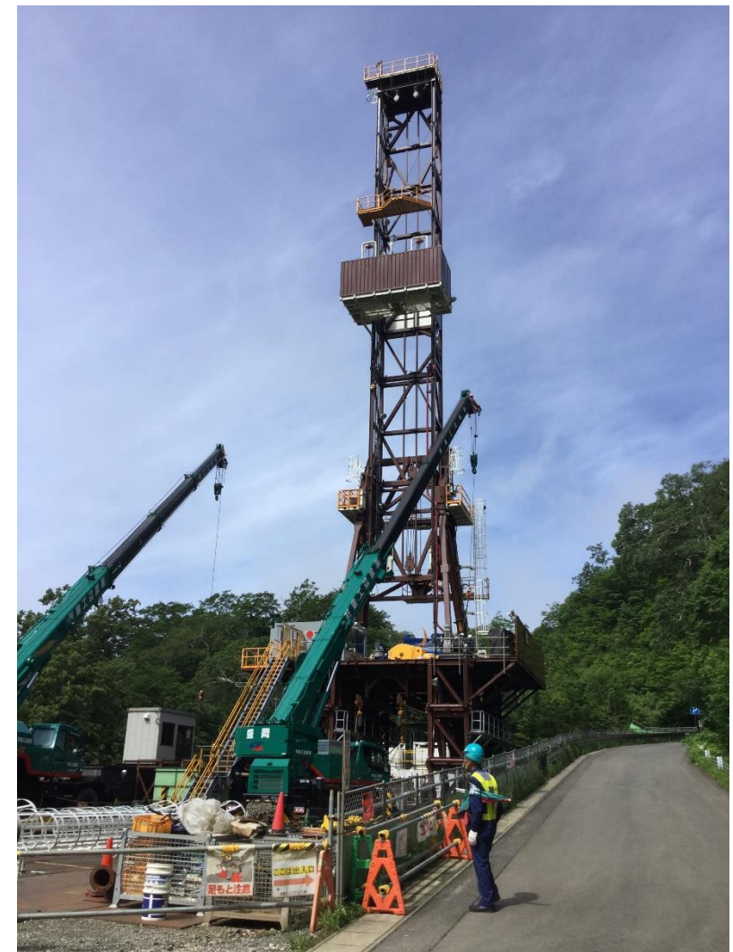
掘削リグ組立状況
