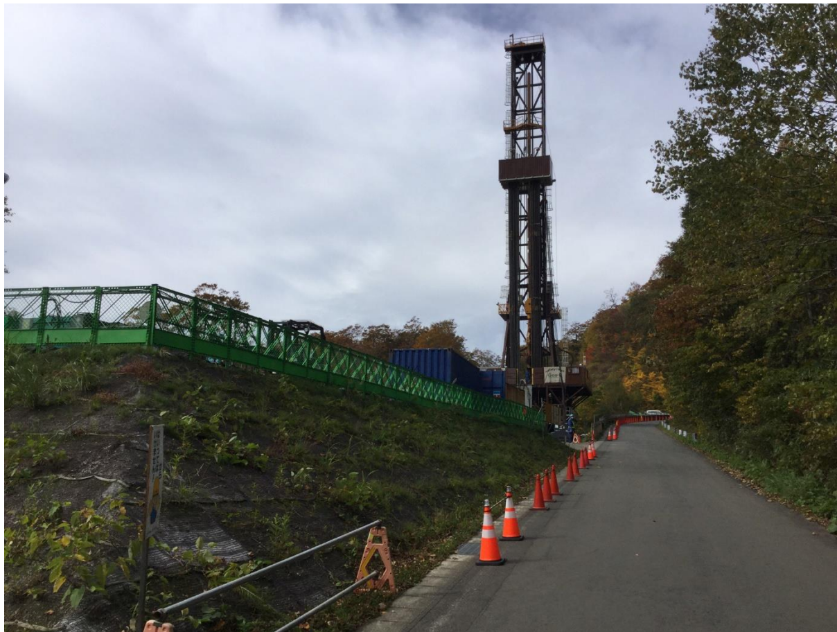
法面緑化状況
