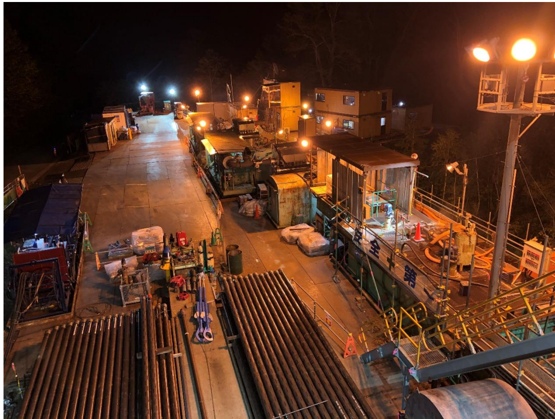
ポンプ付近の照明
