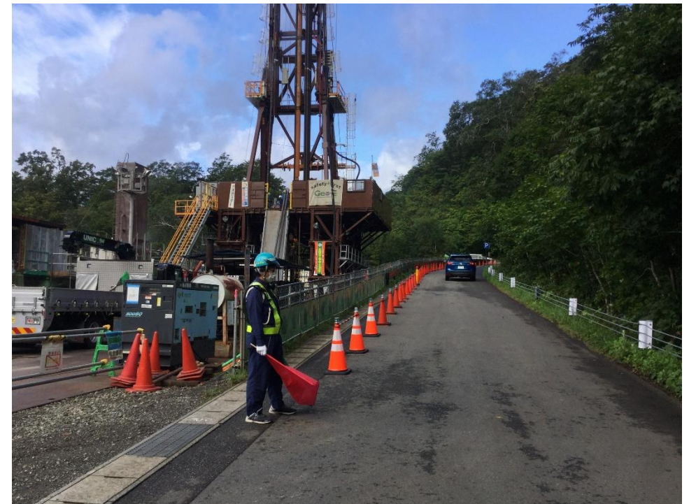
交通誘導員配置状況
