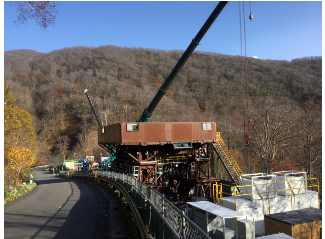
掘削リグ(土台部)
