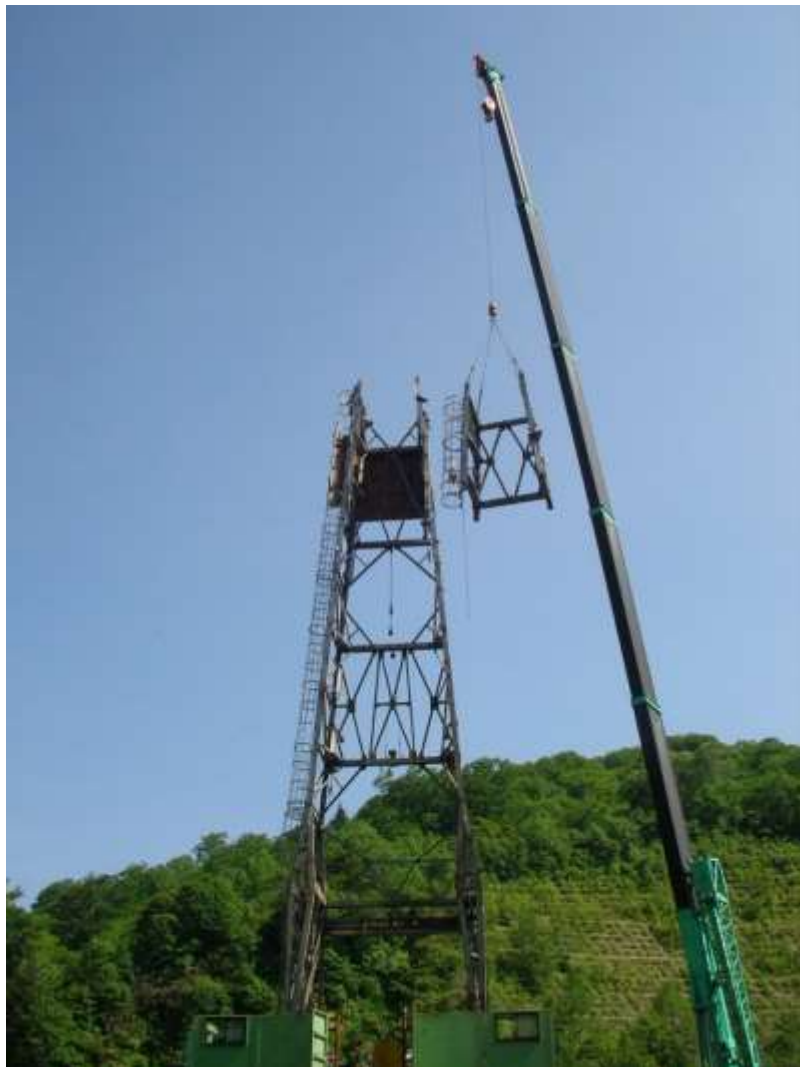
掘削リグ組立
