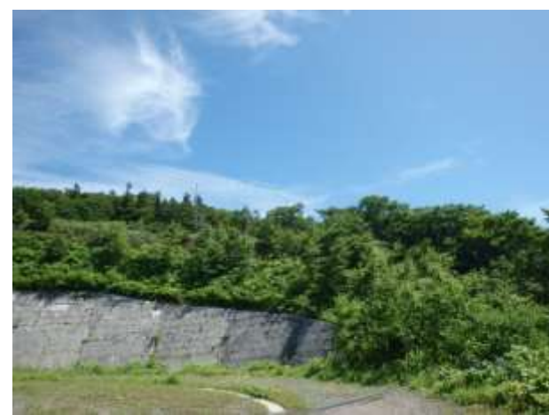
県道終点付近状況
