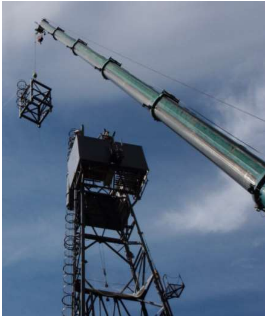
掘削リグ(やぐら部)
