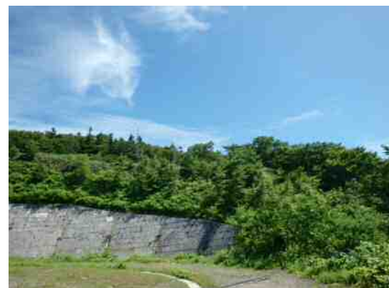
県道終点付近状況
