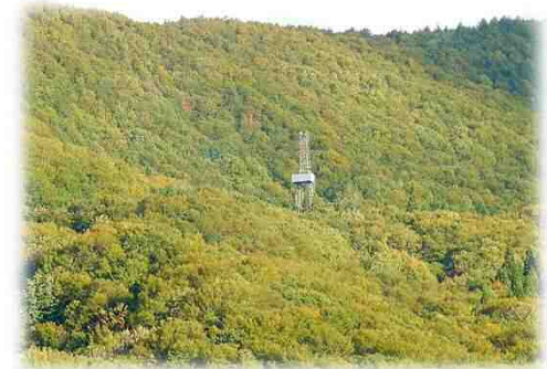
他箇所での掘削調査事例
