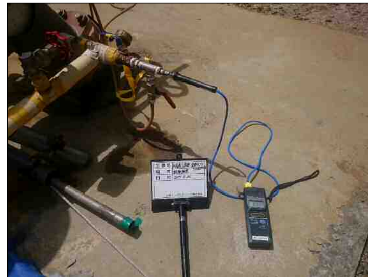
蒸気モニタリング(坑口の温度測定)
