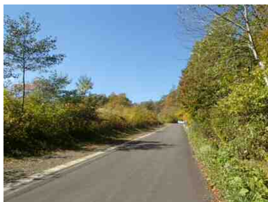
IT-5付近状況
