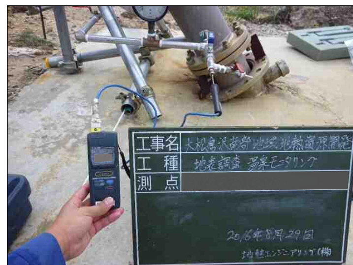
蒸気モニタリング(坑口の温度測定)
