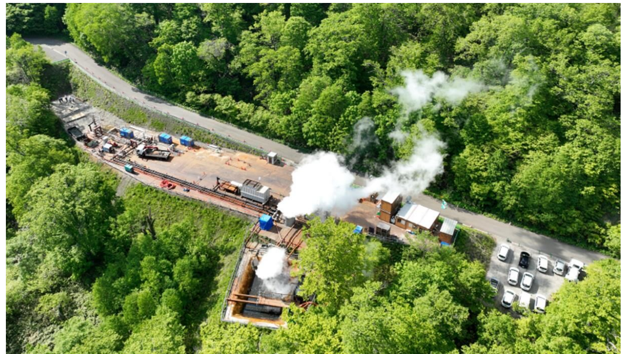
噴気試験状況 (2023年6月6日ドローン撮影)
