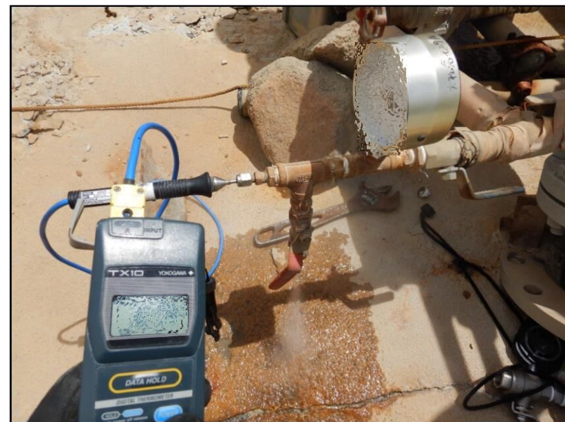
蒸気モニタリング(坑口の温度測定)
