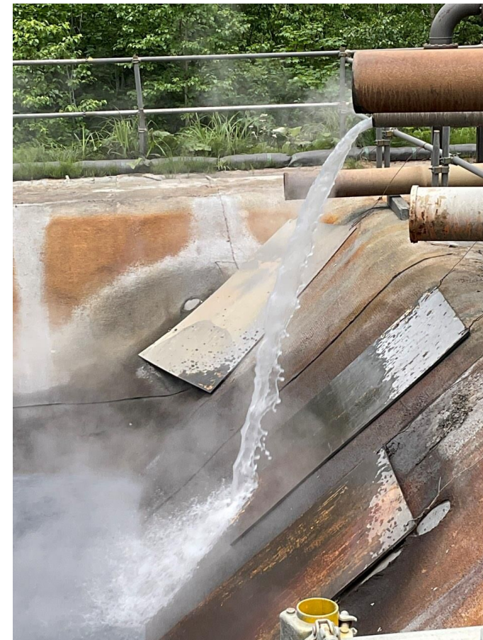
ピットへの熱水排出状況
