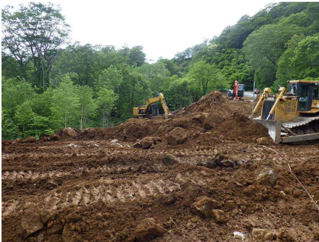
造成工事状況
