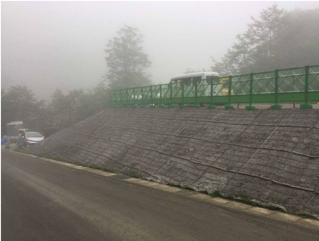
植生マット設置状況
