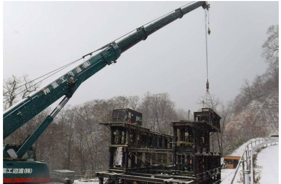
掘削リグ(土台部)
