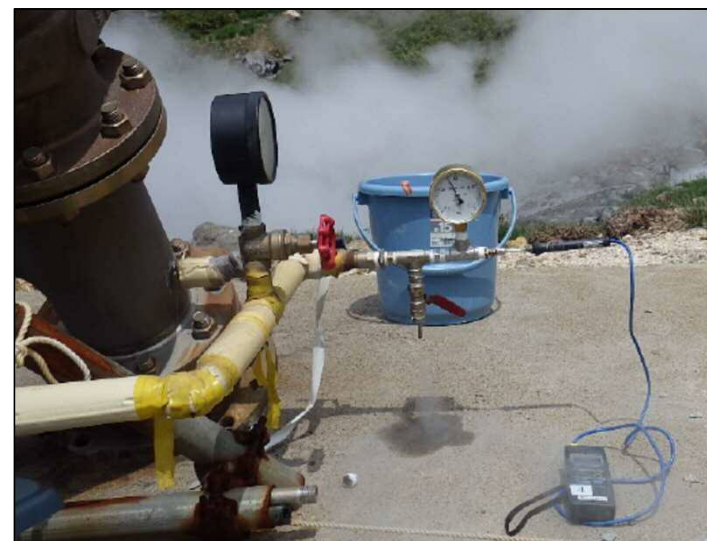
蒸気モニタリング(坑口の温度測定)
