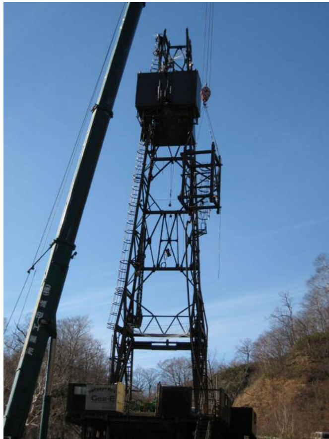
掘削リグ(やぐら部)
