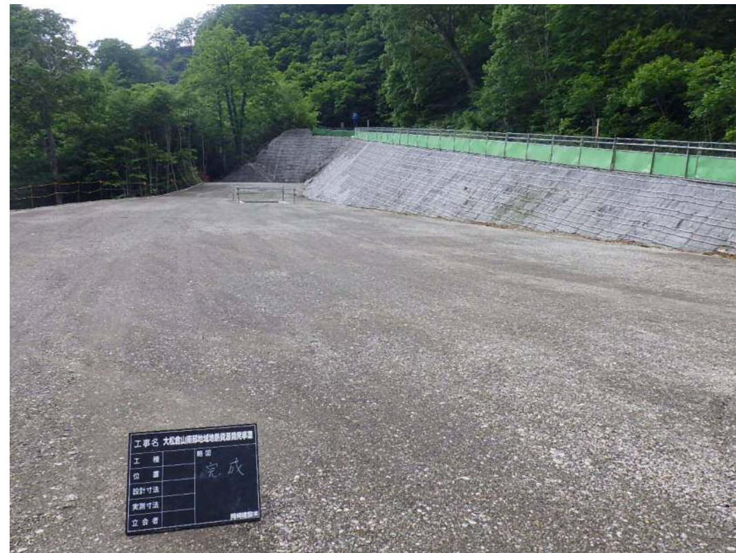
造成完了写真
