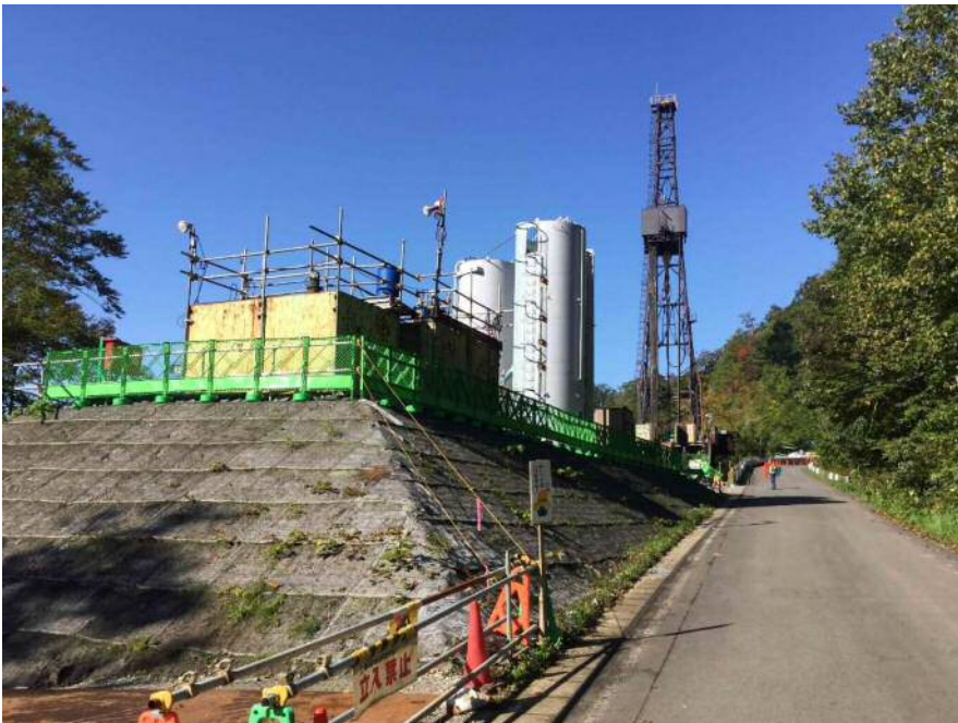
フェンス設置状況
