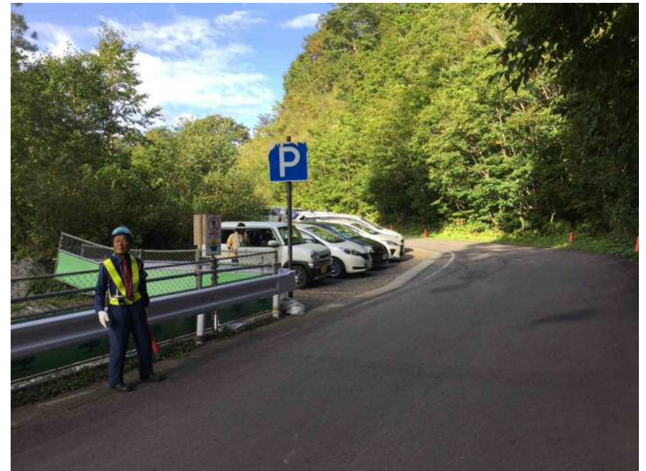
交通誘導員配置状況
