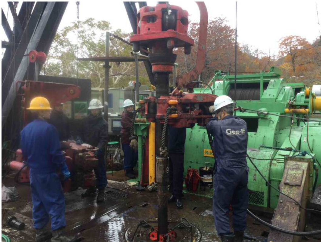
掘削作業状況
