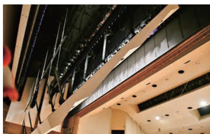
昇降機で反射板を降ろします
