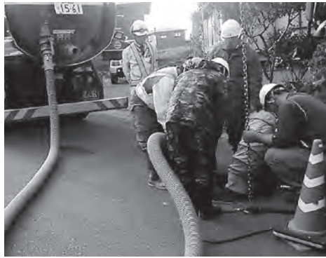
▲詰まった異物の吸引作業
