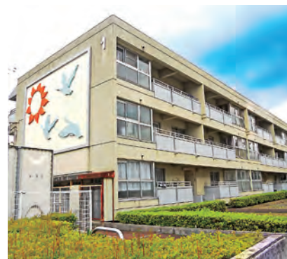
▲③源大堂住宅
