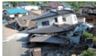
2016年に発生した熊本地震で被災した家屋
