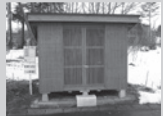
補助制度を活用して設置された板橋行政区のごみ集積所
