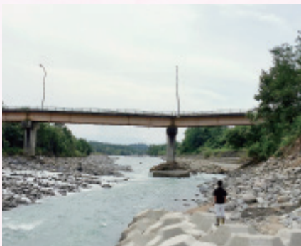
8月24日の大雨で沈下した西長橋
