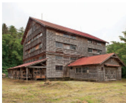
指定された施設のひとつ「四階建倉庫」
