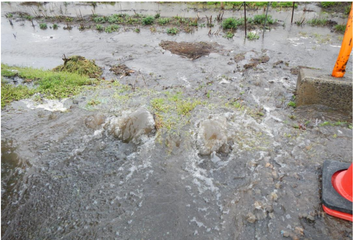
＜配水管の老朽化による漏水事故 場所：上野下川原地区 平成28年4月＞
