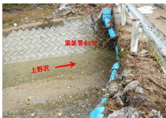
（豪雨により上野沢上流から流木が流れ、水管橋が破壊された様子）
