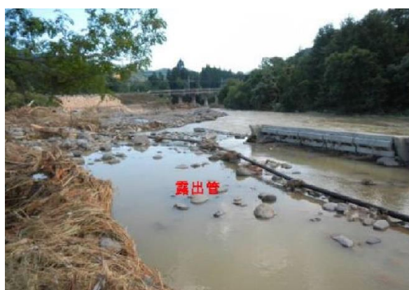
（雫石川の氾濫で土砂が押し流され、埋設していた管路が露出した様子）
