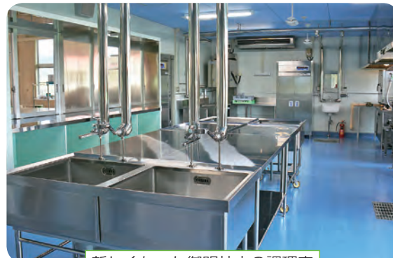
新しくなった御明神小の調理室
