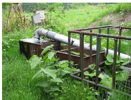
図 37 岩手県営屋内温水プールの地下水熱ヒートポンプ
