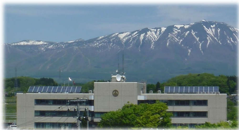
役場庁舎屋上の太陽光発電施設
