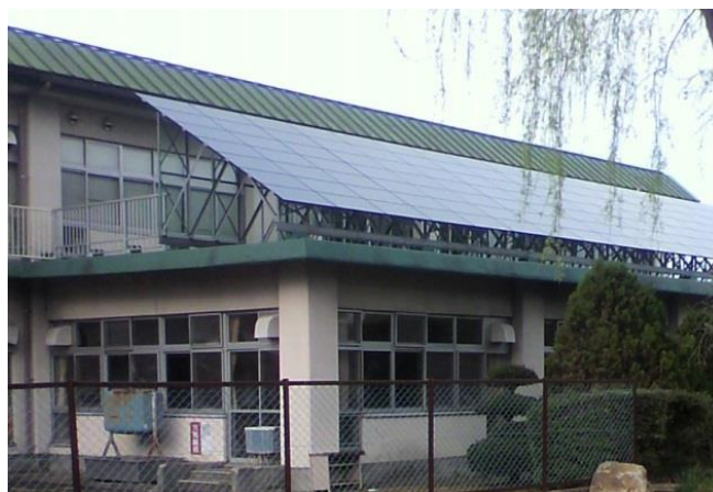
図 28 雫石町立西根小学校の太陽光発電パネル
