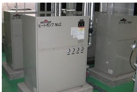
図 37 岩手県営屋内温水プールの地下水熱ヒートポンプ
