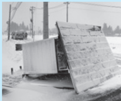
強風の影響で倒れた中南行政区内のごみ置き場。多くの家屋も被害に遭いました
