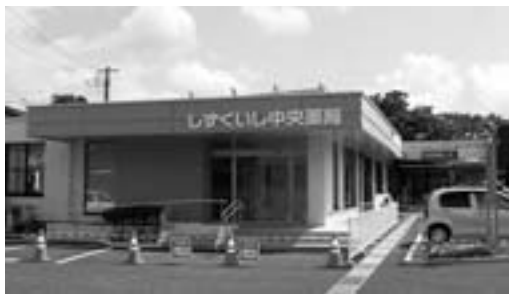
10月からの院外薬局開設に向けて改修工事が進む保健センター
