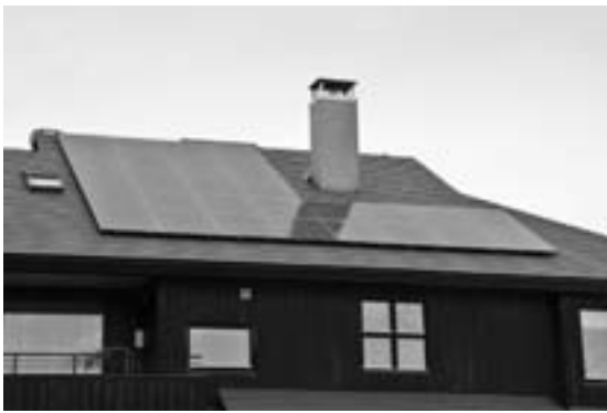
住宅に設置された太陽光発電設備
