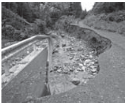
大雨で流失した林道志戸前川線
