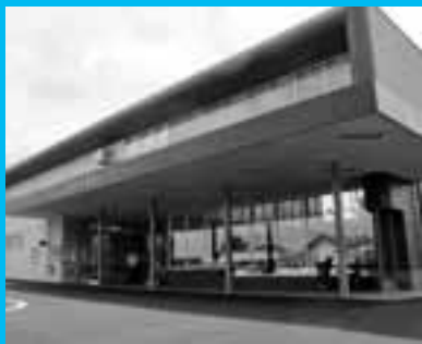
診療所跡地に完成した 雫石町健康センター
