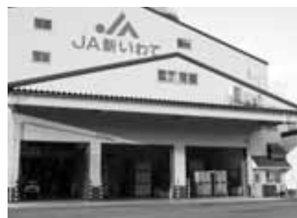
町内各地から収穫されたコメが集まる 雫石カントリーエレベーター
