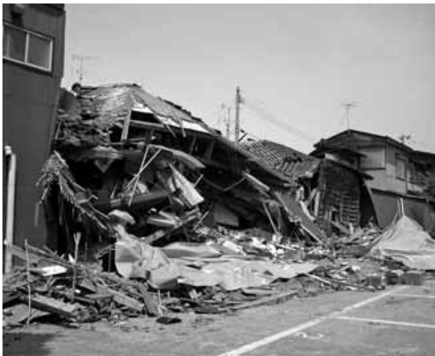
平成16年新潟県中越地震で倒壊した家屋
