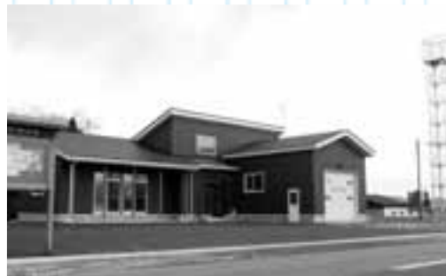
3月28日に落成した黒沢 コミュニティ消防センター
