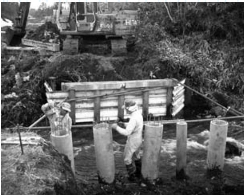
地区民総出で修復した橋
