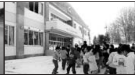
安庭小学校校舎整備
