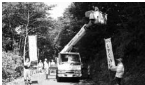
高所作業車を使い枝を払う作業員
