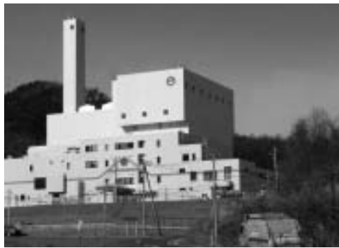
平成19年度からごみ処理業務を委託している滝沢村ごみ処理場
