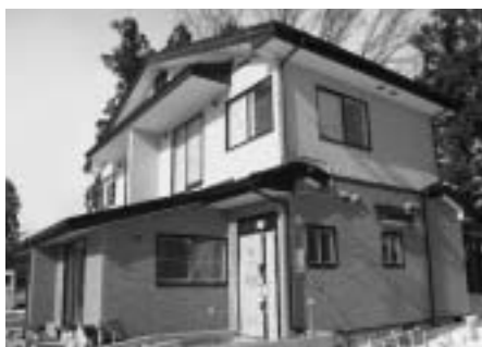
町営春木場住宅
