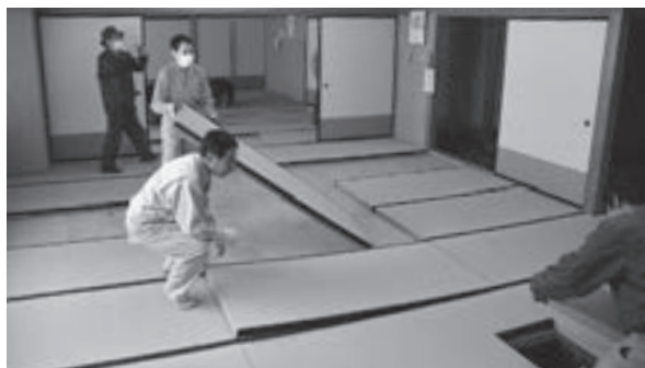
畳の入れ替え作業の様子
