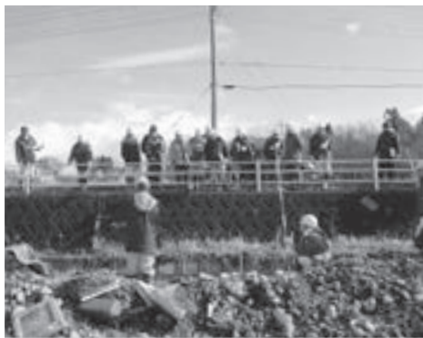
災害査定の様子（11月21日）
