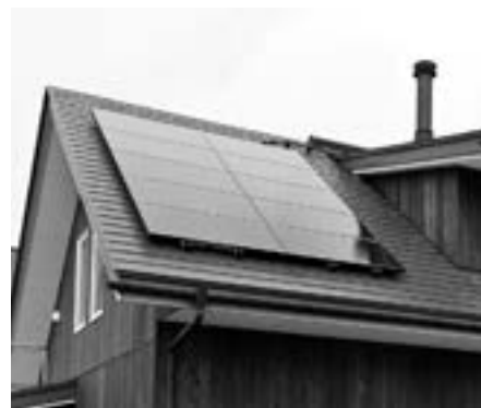
本事業を活用し設置された設備
