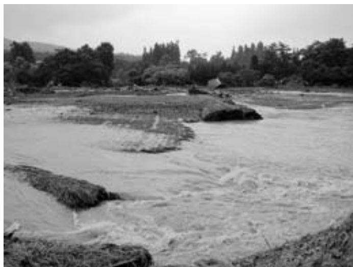
大雨により土砂が流入した田んぼ（小赤沢地区）
