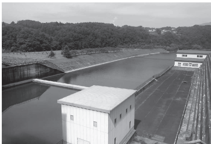
大量の土砂が堆積する御所ダム
