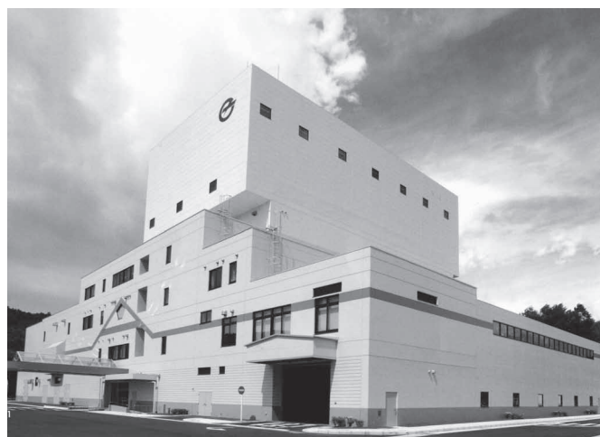
雫石・滝沢環境組合で運営する滝沢村清掃センター
