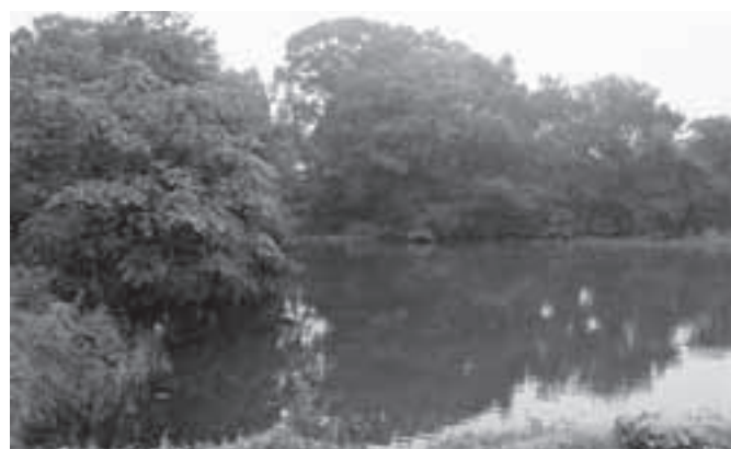
老朽化による漏水があった旭台のため池
