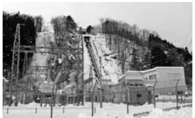
長年使用されている葛根田第2発電所
