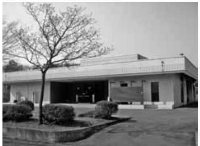
老朽化が進む町営火葬場
