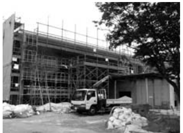
年内完成に向け建設が進む（仮称）町立健康センター
