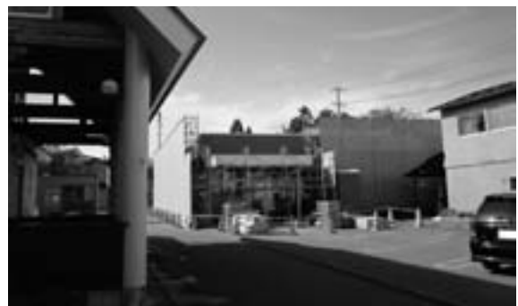
中町のふれあいひろば内に設置されるまちおこしセンター
