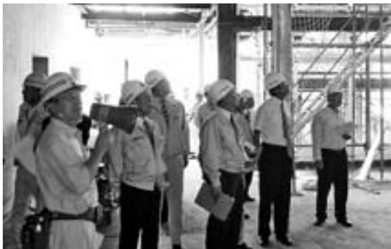
工事の進捗状況を確認する委員
