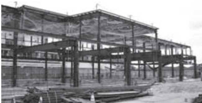
建設が進む町立健康センター（仮称）
