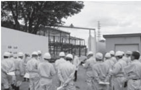
雫石健康センター建設現場
