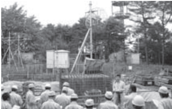
生森山山頂の地上デジタル放送のアンテナ工事現場
