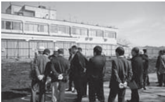
町立健康センター（仮称）建設現場の調査
