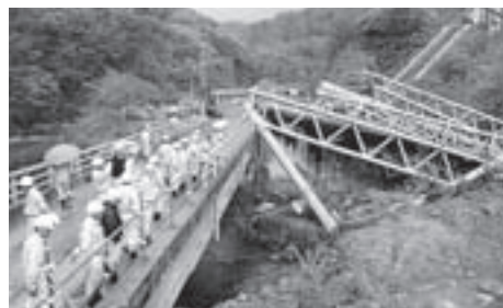
土砂の崩落により一部が埋まった県道西山生保内線などを全議員で調査
